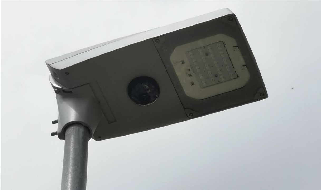
Neue LED-Leuchte mit intelligenter Steuerung
