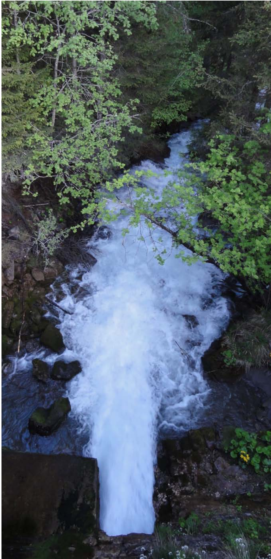
Wasserablass beim Stausee Stettli
