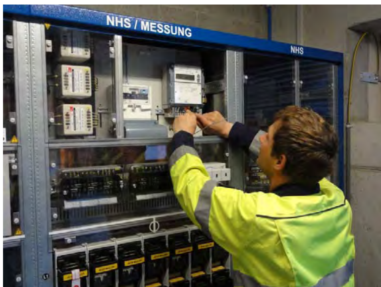
Zählerwechsel mit Umstellung auf Doppeltarif
