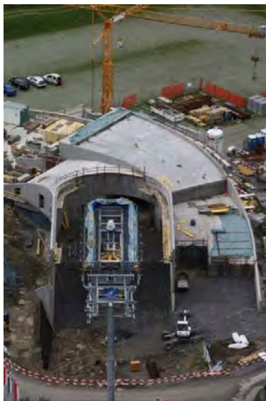
Bau Portal: runde Wände
