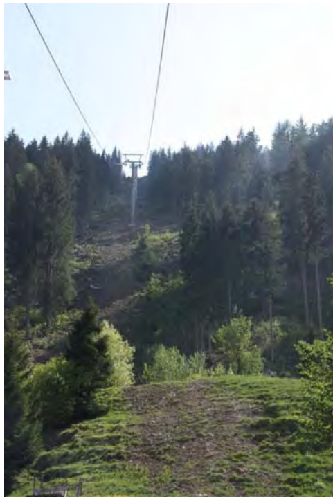
In steilem Gelände wurde die Mittelspannungsleitung eingezogen.
