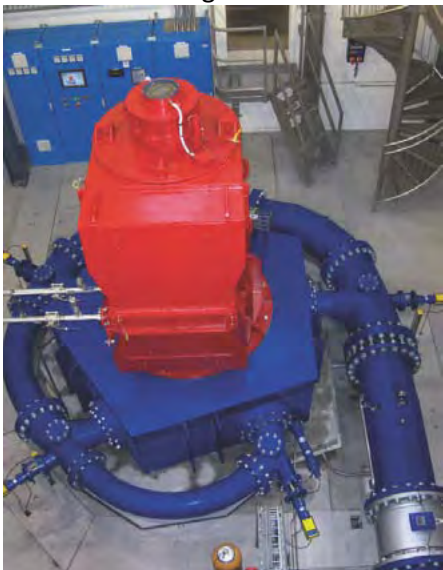
Rabiosa-Maschine mit einer Leistung von knapp 700 kW
